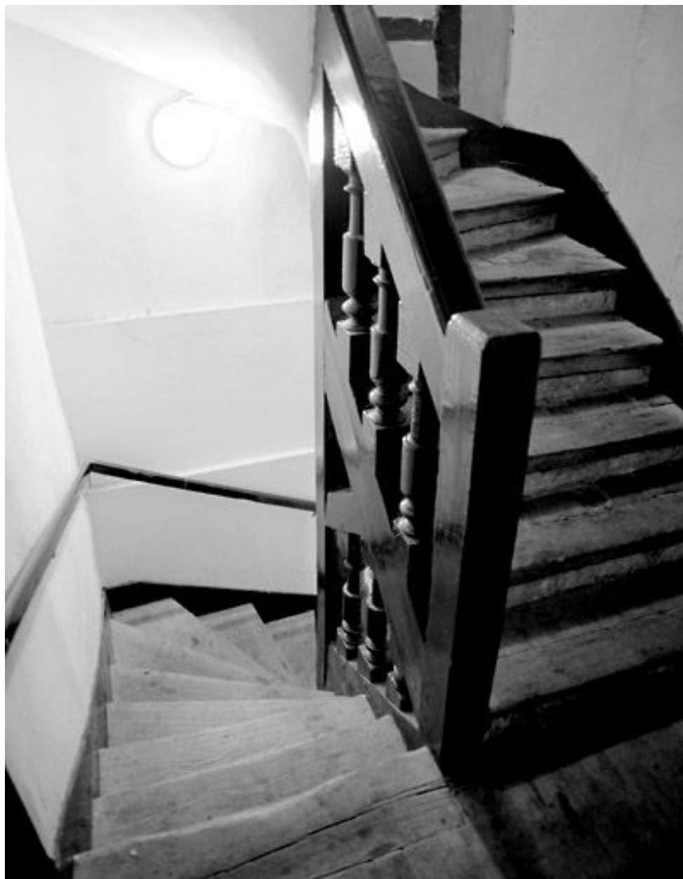
Vue de l'escalier.
