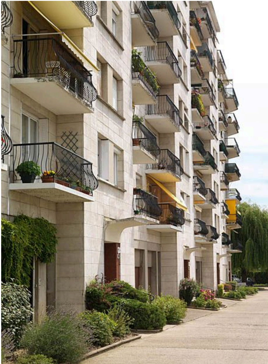
Résidence de l'Eglise". Détail de la façade arrière.
