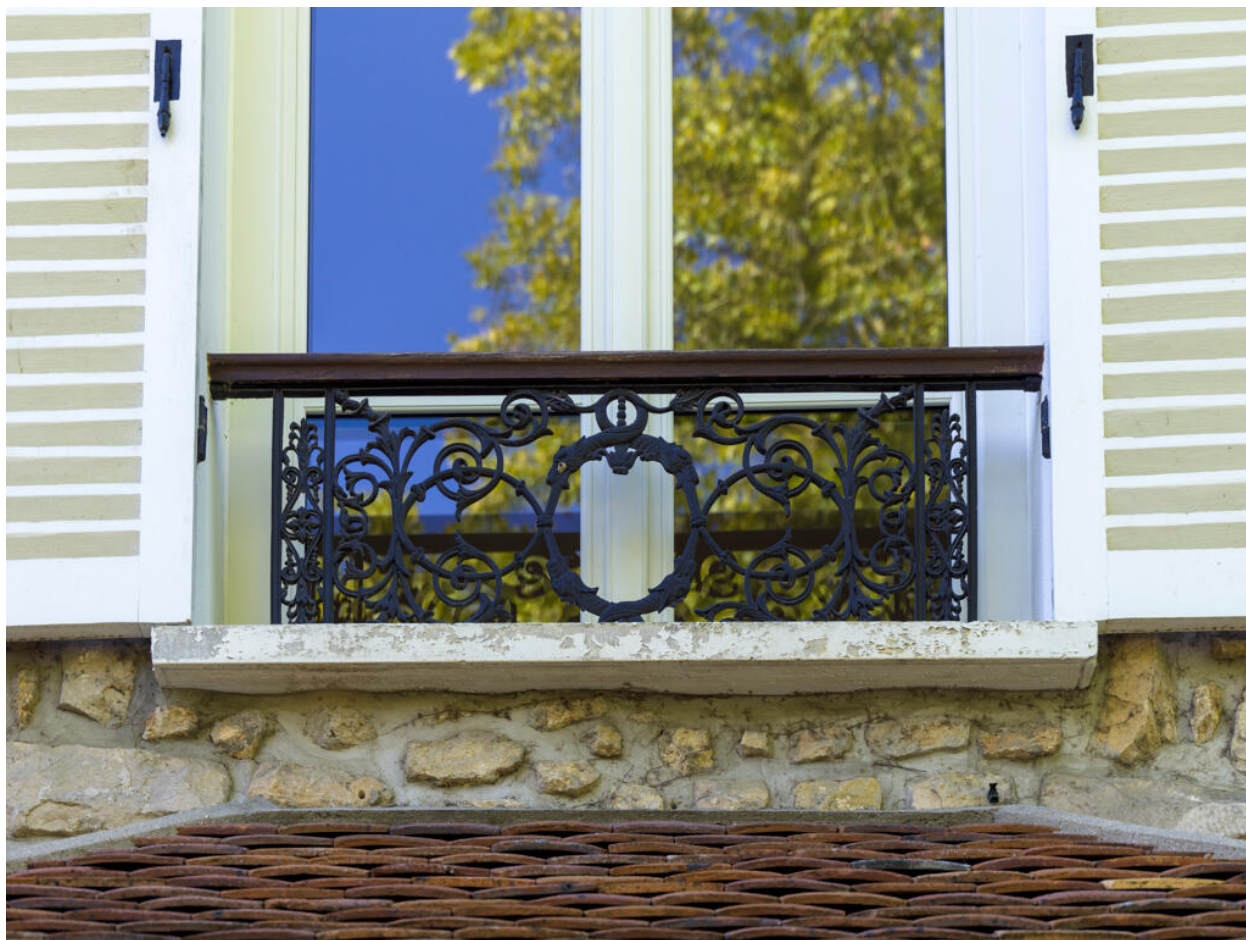
Détail d'un garde-corps d'une fenêtre de l'étage de la façade sur cour.
