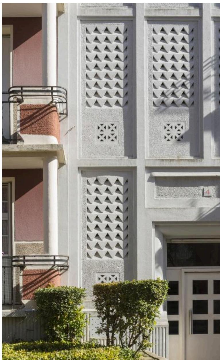
Détail de la cage d'escalier
