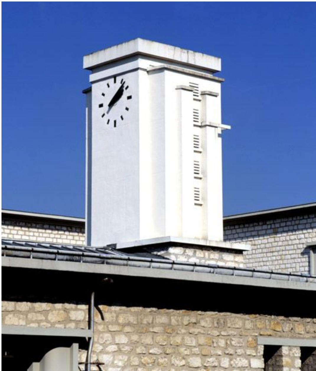
La chaufferie : cheminée avec horloge.
