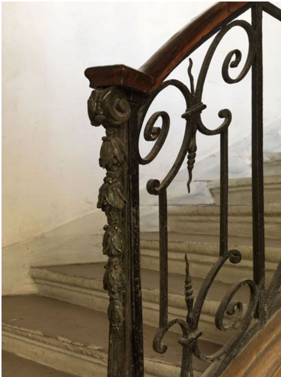
Détail de la console de départ.
