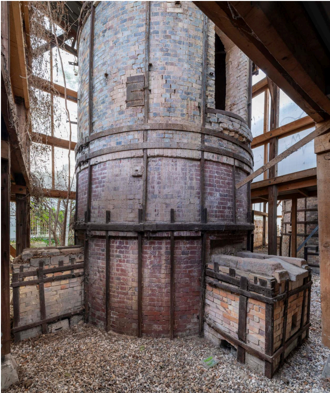
Base du four rond à globe et à flamme renversée, brevet 1878, mis en place avant 1912.
