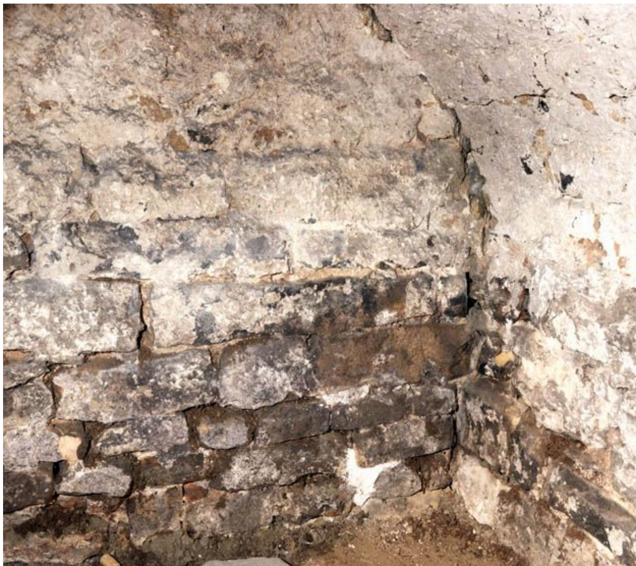
Détail de la maçonnerie de la niche occidentale.
