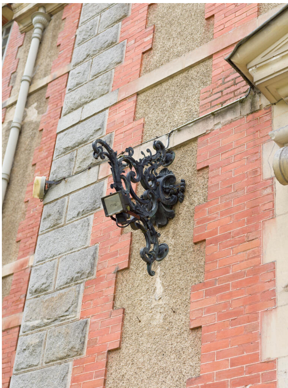
Détail d'un bras de lumière sur la façade antérieure.
