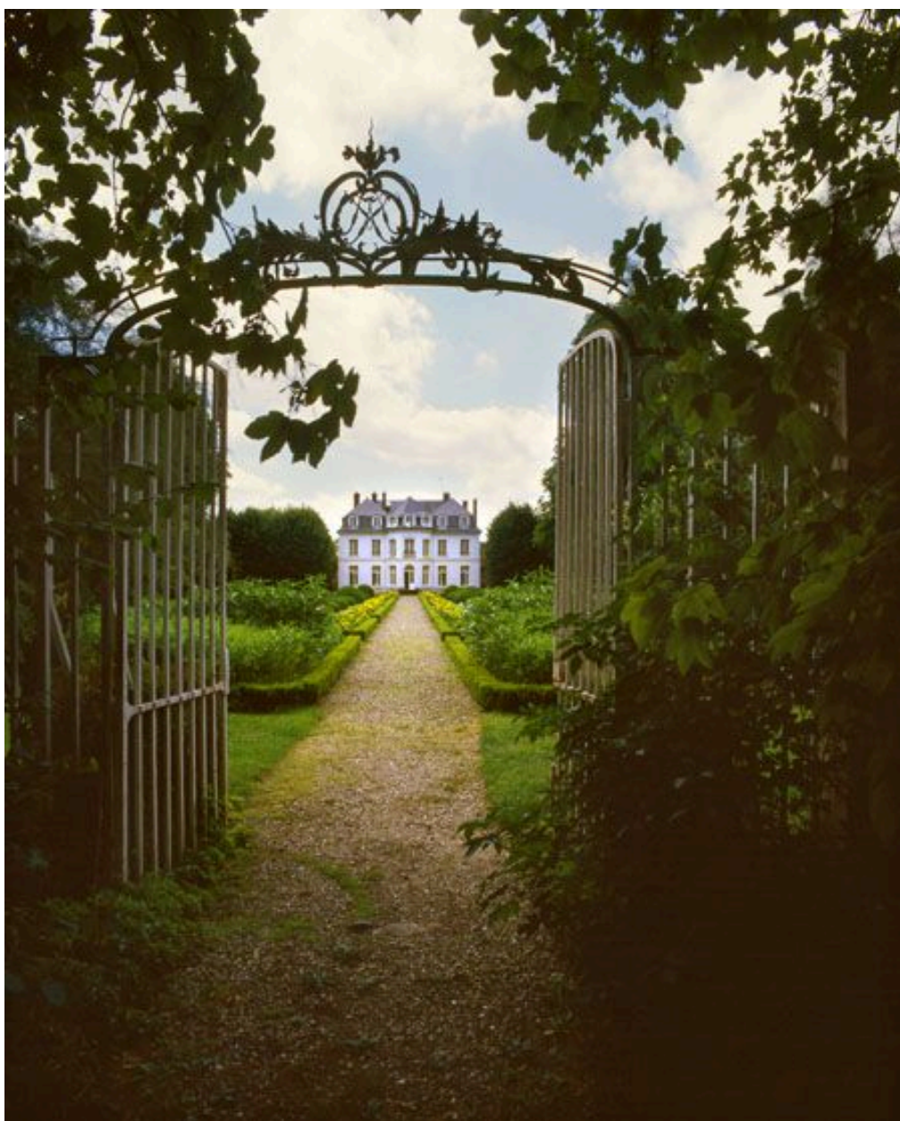
Le château vu depuis la grille donnant sur la partie boisée du parc.
