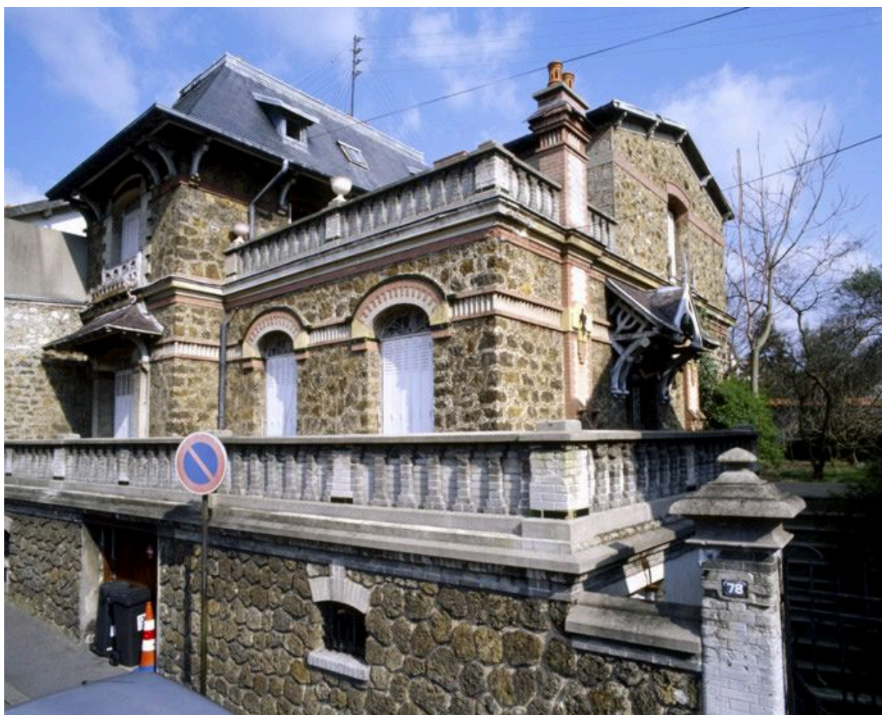
Maison, 78 rue Albert Darmont. Vue d'ensemble depuis la rue.
