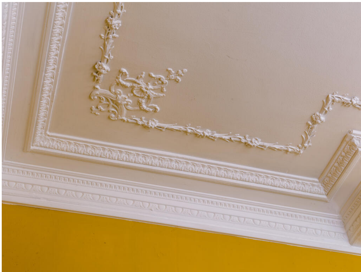
Détail d'un plafond mouluré du rez-de-chaussée.
