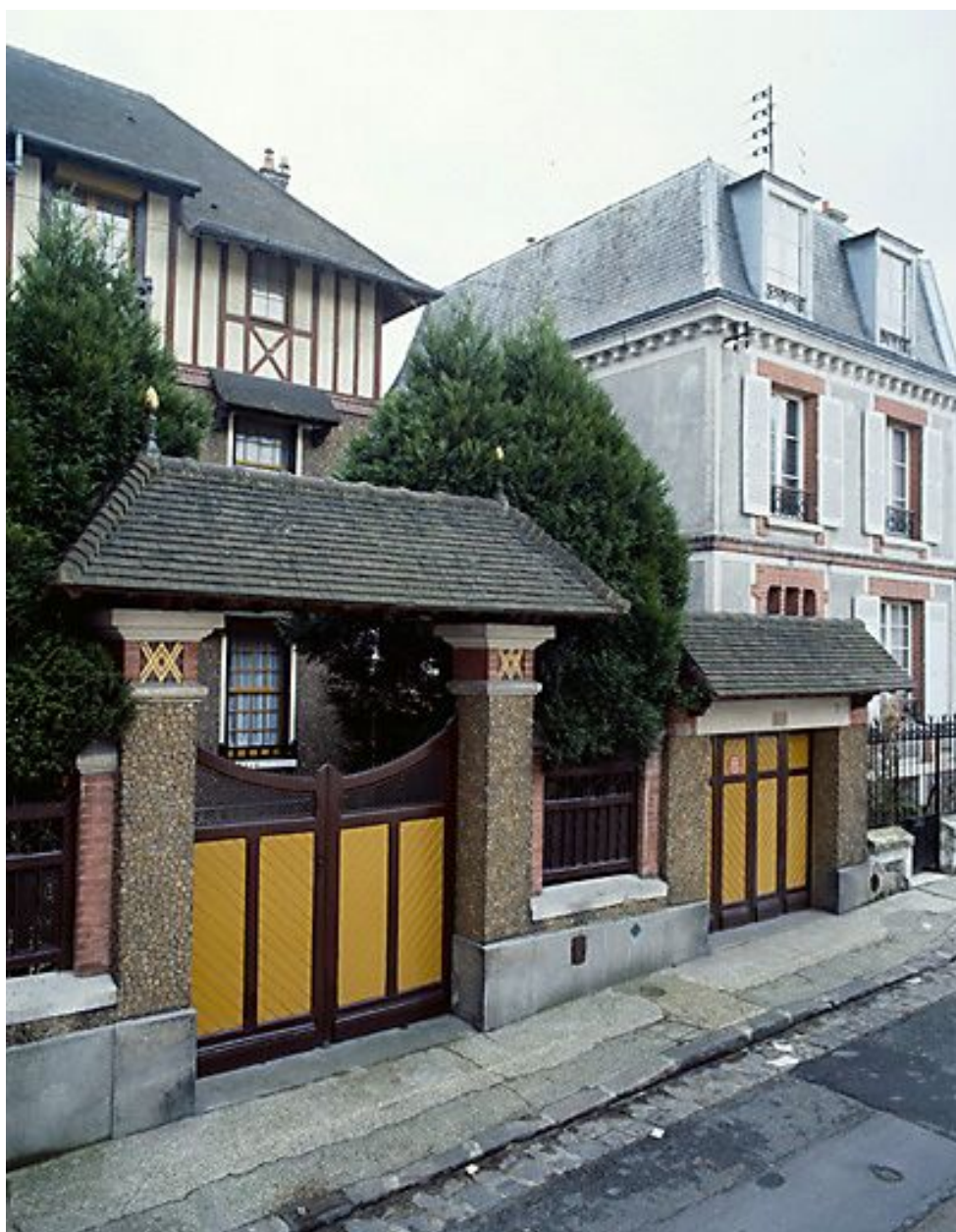
Vue partielle de la façade antérieure et portail d'entrée.
