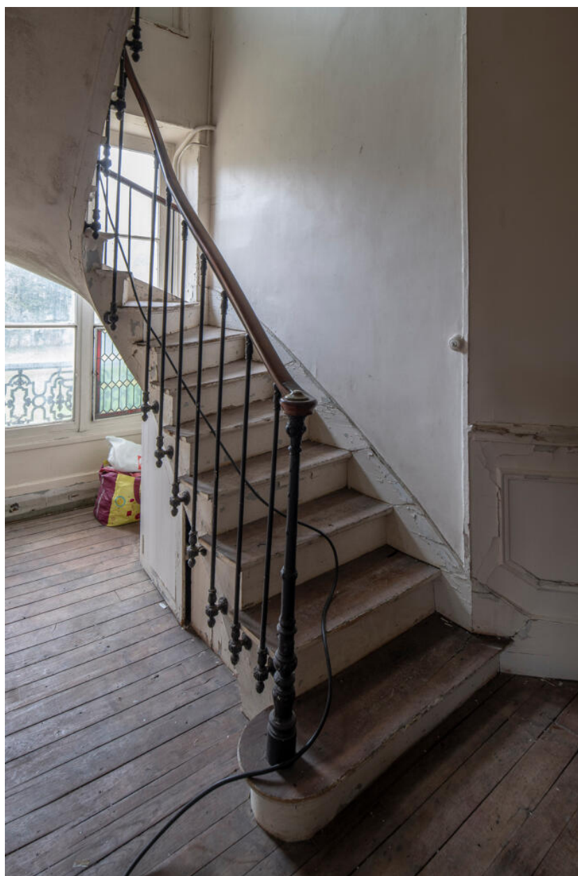
Escalier d'accès à l'étage de comble.
