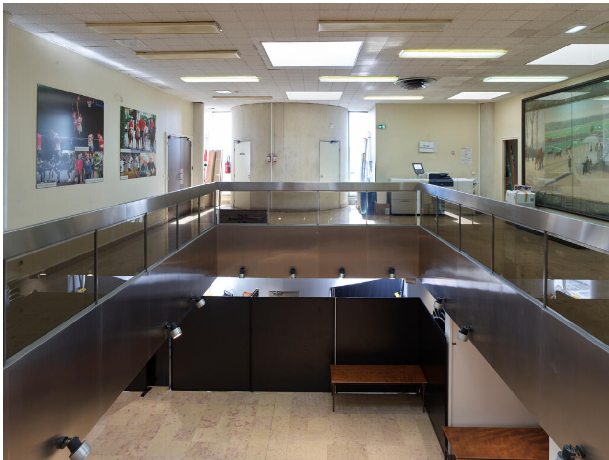
Garde-corps en verre fumé des trémies du deuxième étage.
