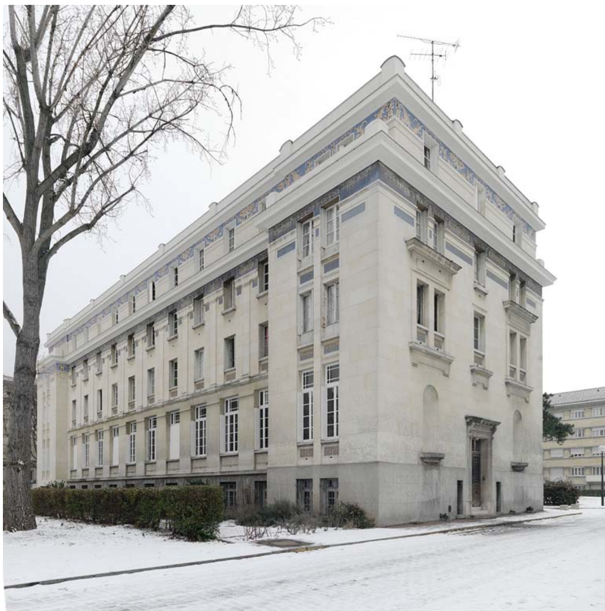
La façade arrière et la façade latérale ouest.
