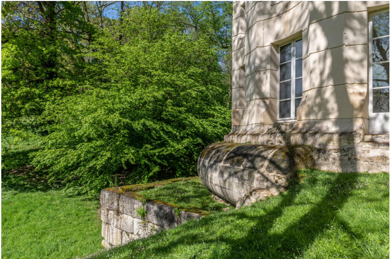
Détail du mur de soubassement.
