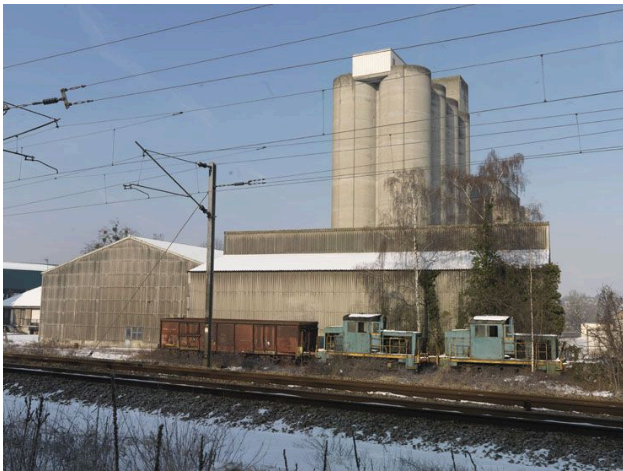
Bonnières-sur-Seine, silos de la société anonyme des silos de Bonnières, quai de Seine. Vue des silos depuis la voie ferrée.
