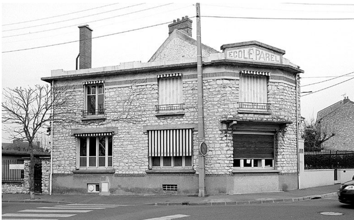
Vue de la façade.
