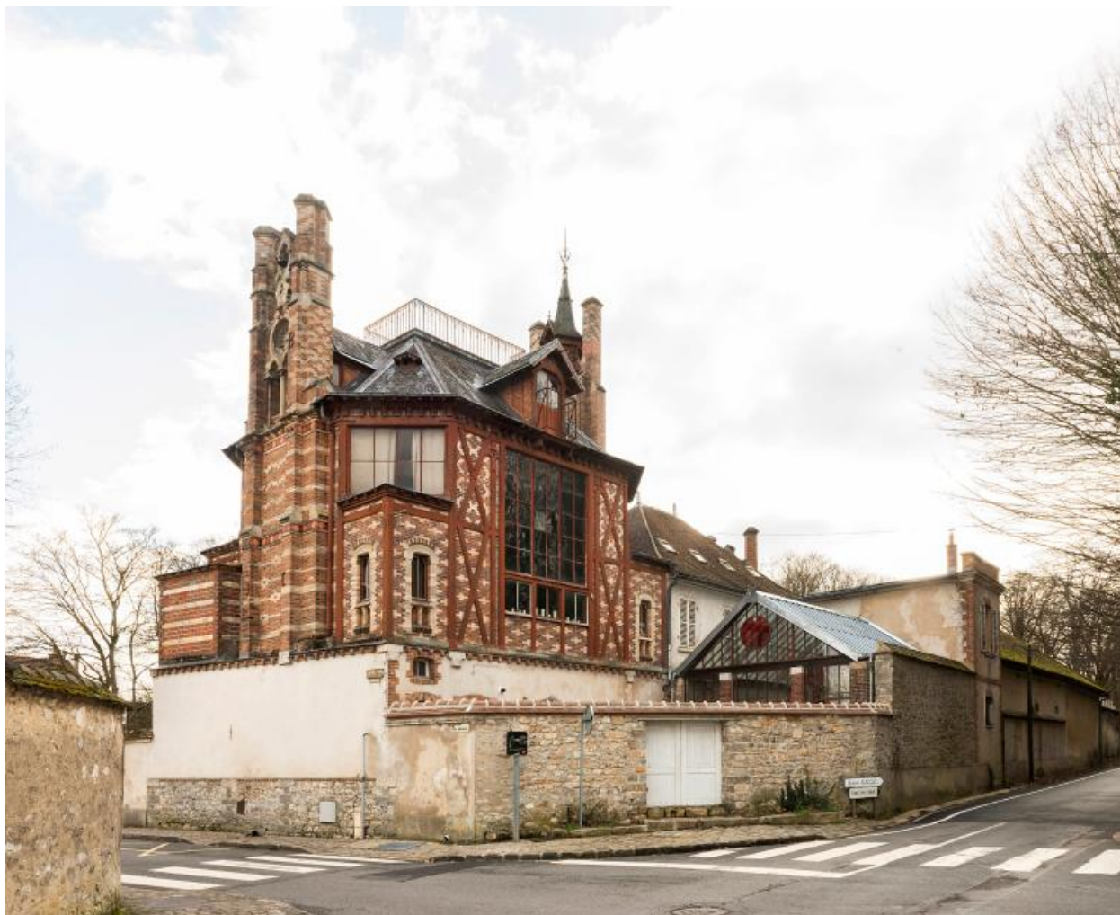
Vue d'ensemble de l'atelier (1)
