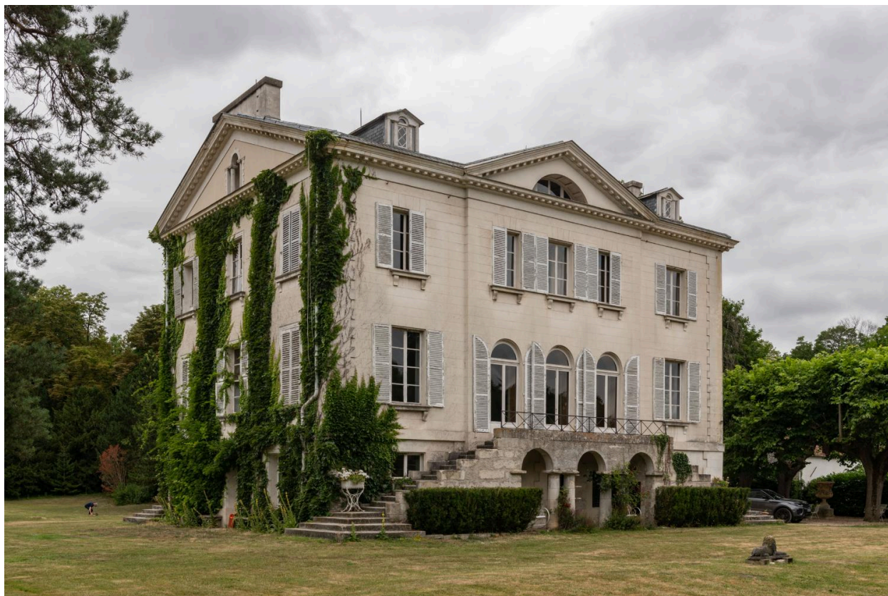
Façade postérieure, plein est, et façade latérale sud
