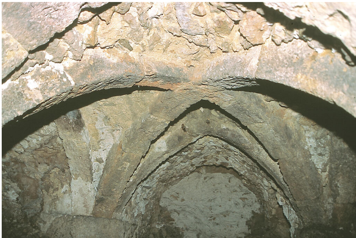
Vue des caves médiévales.
