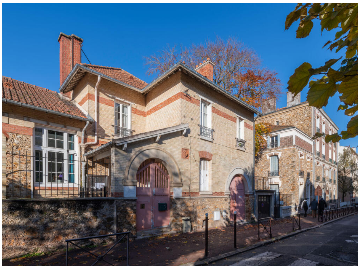
École maternelle de Montretout, pavillon de la direction, vue depuis la rue
