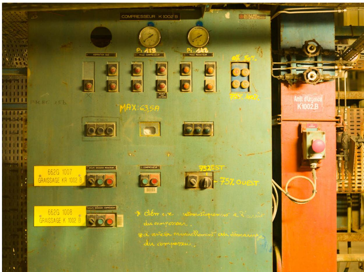
Unités Ouest - Hydrodésulfuration des gasoils "HDS" - HDS 2 (Unité 662). Tableau de contrôle du compresseur alternatif 662 K1002 B.
