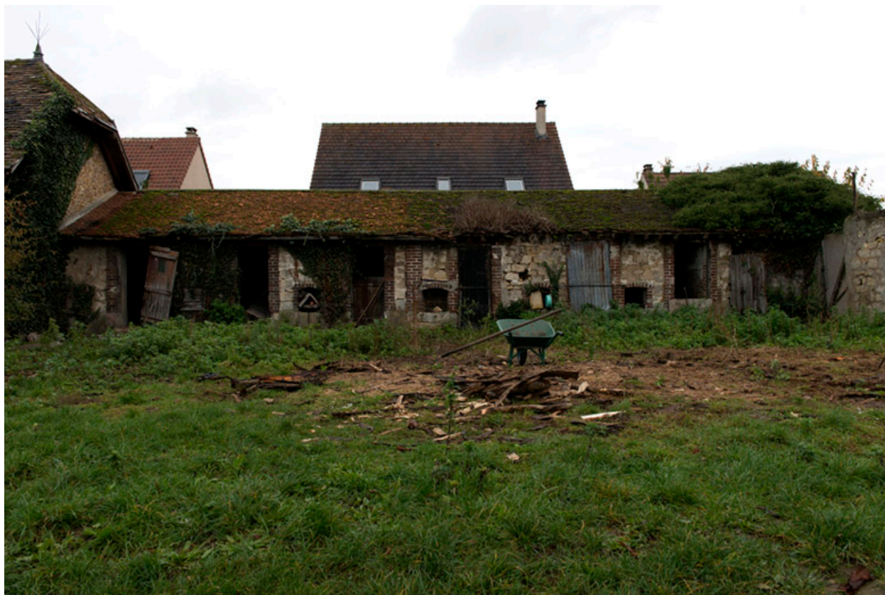
Bâtiments en ruine le long du côté est de la cour.
