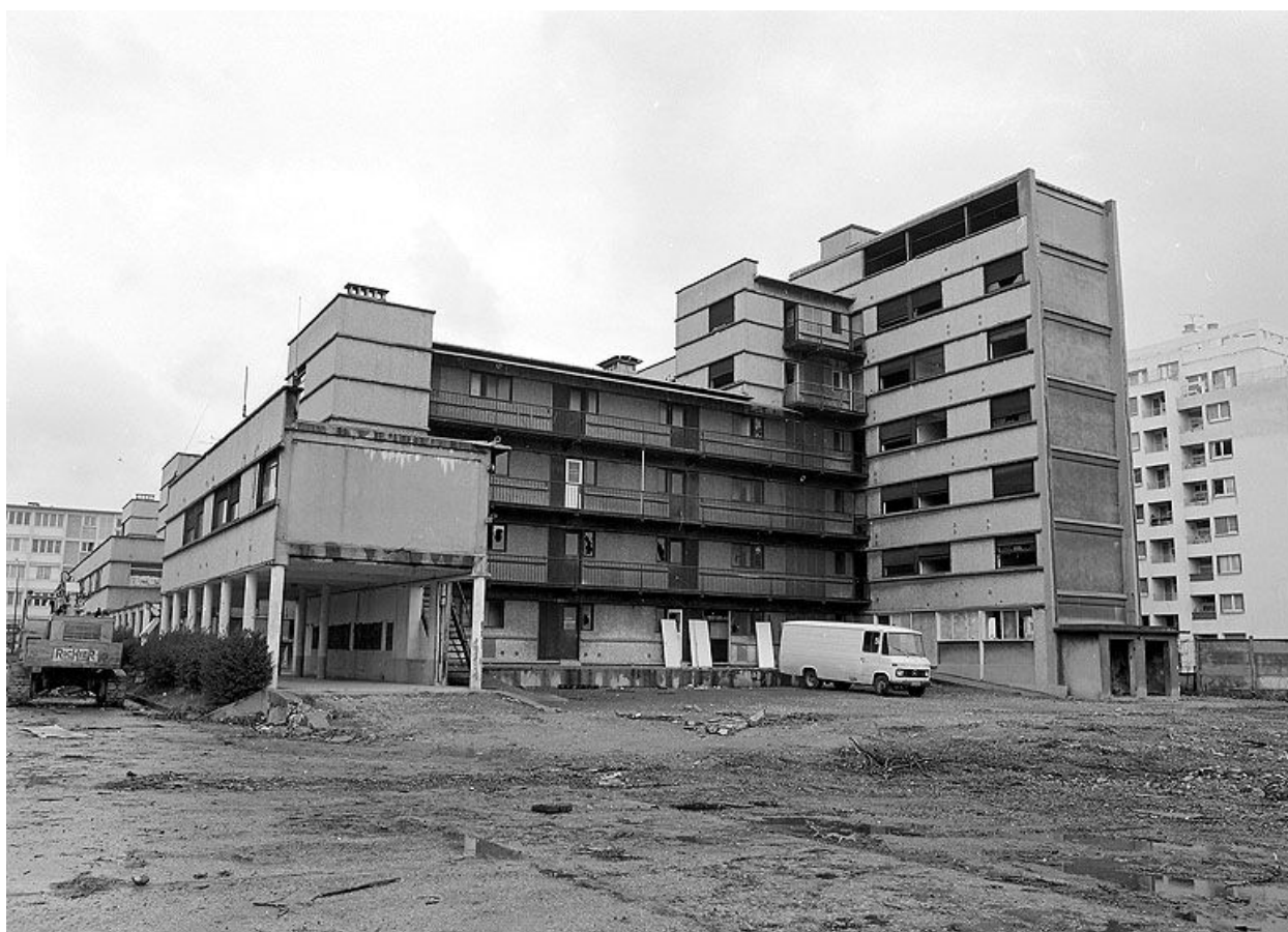
Bâtiment A, façade ouest. Campagne photographique, lors de la destruction du bâtiment en 1976.
