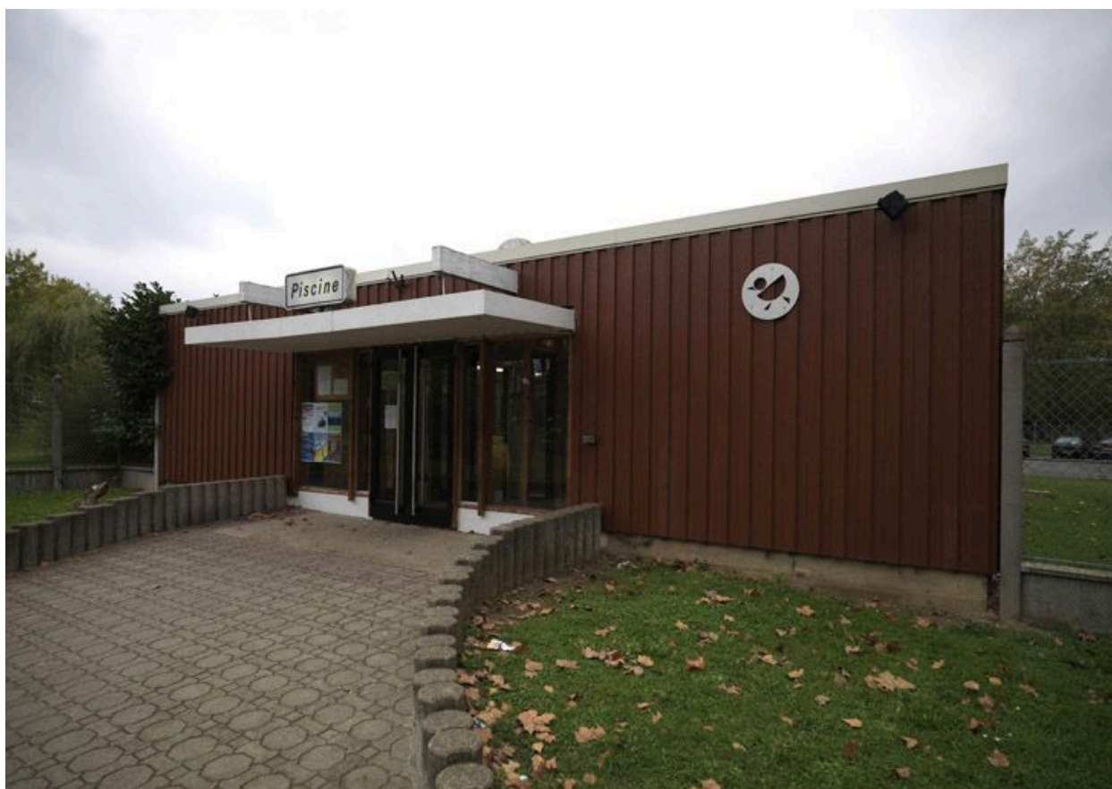
Vue de la façade d'entrée du bâtiment.
