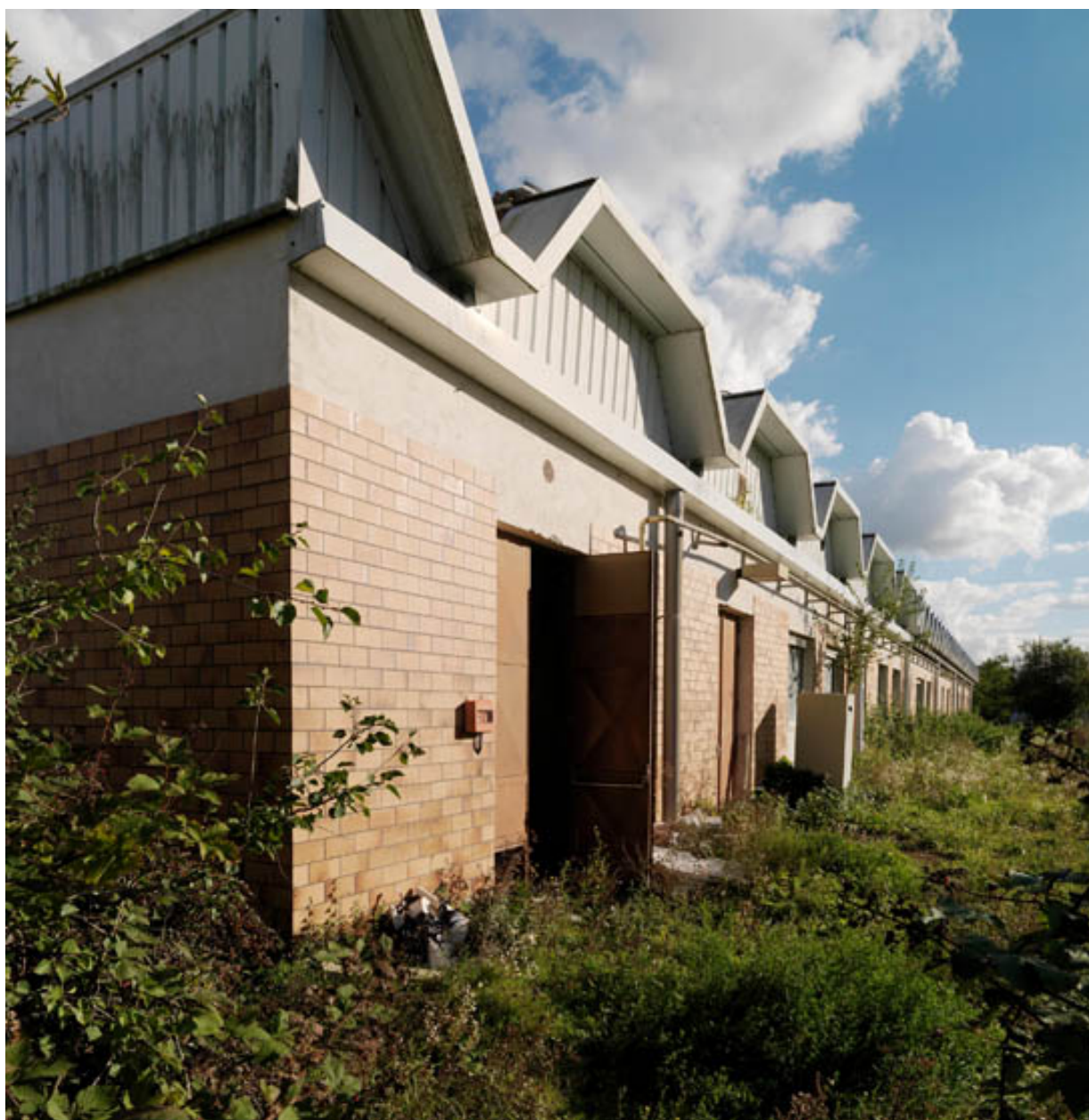
Vue extérieure de l'atelier des circuits imprimés (1979-1981), couvert de sheds en coques "M" autoportantes.
