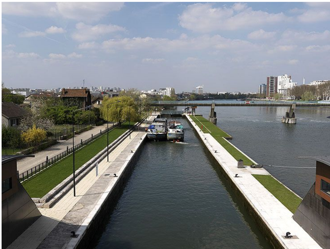
Alfortville, Vitry-sur-Seine. Barrage éclusé de Port-à-l'Anglais. L'écluse.
