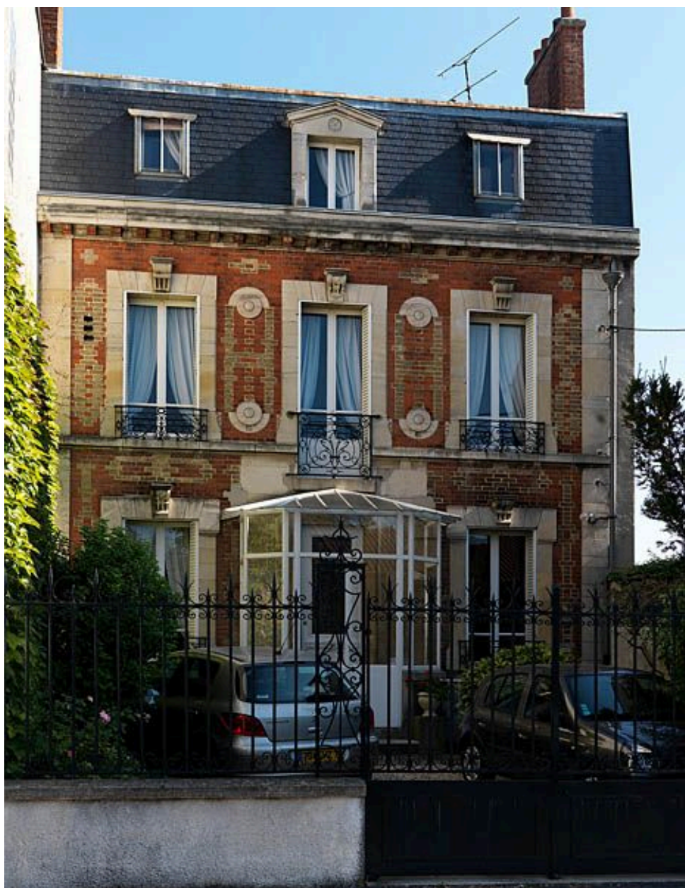
Maison au 36, rue Saint-Faron, avec façade à parements de brique.
