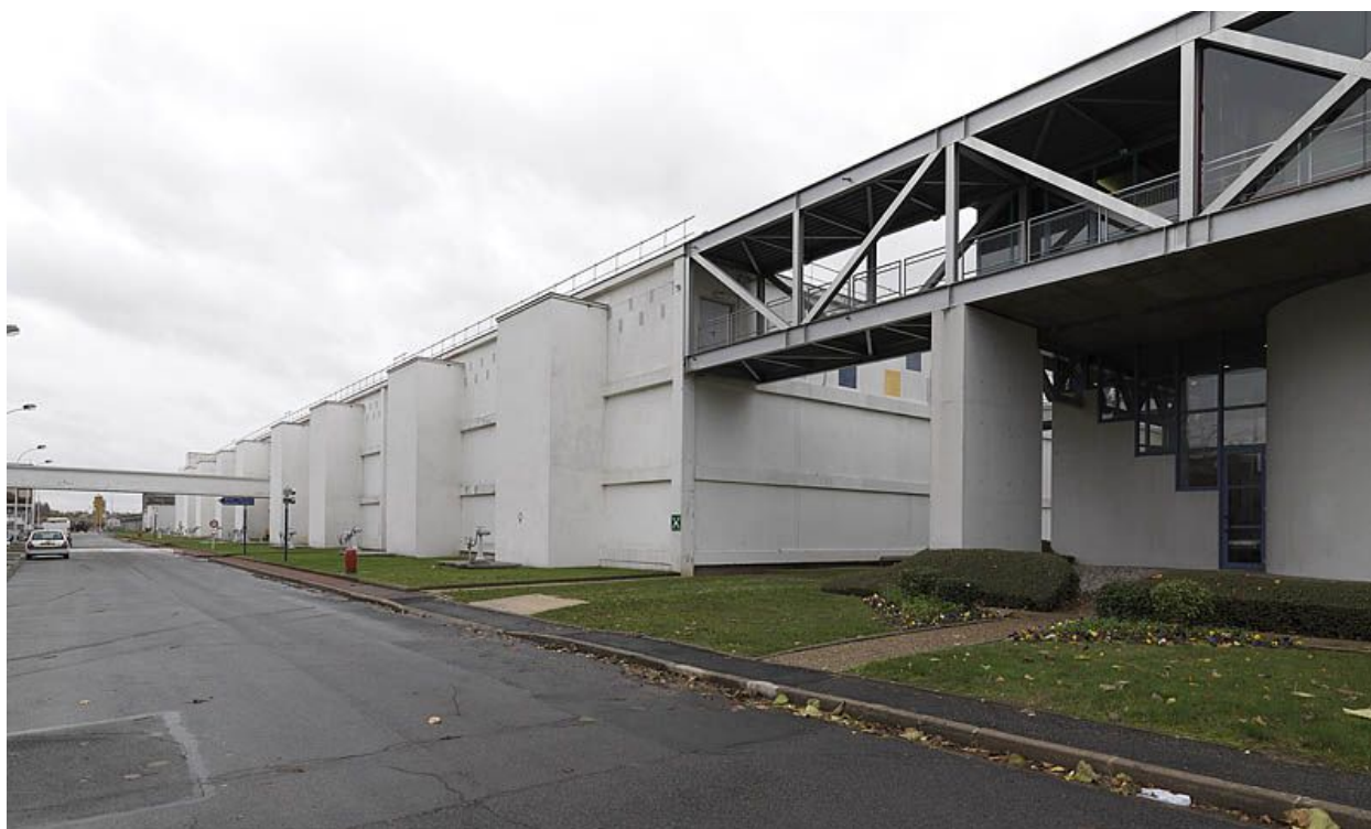
Choisy-le-Roi, établissement des eaux dit usine de traitement des eaux de Choisy. Vue des bassins de décantation.
