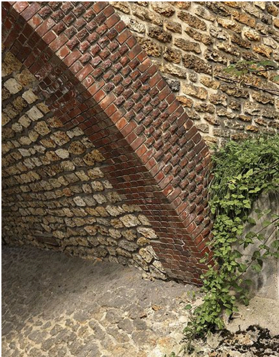
92, Meudon, pont ,rue du Docteur-Vuillième. Détail de l'appareil de briques sculptées en bossage de l'arcature du pont.
