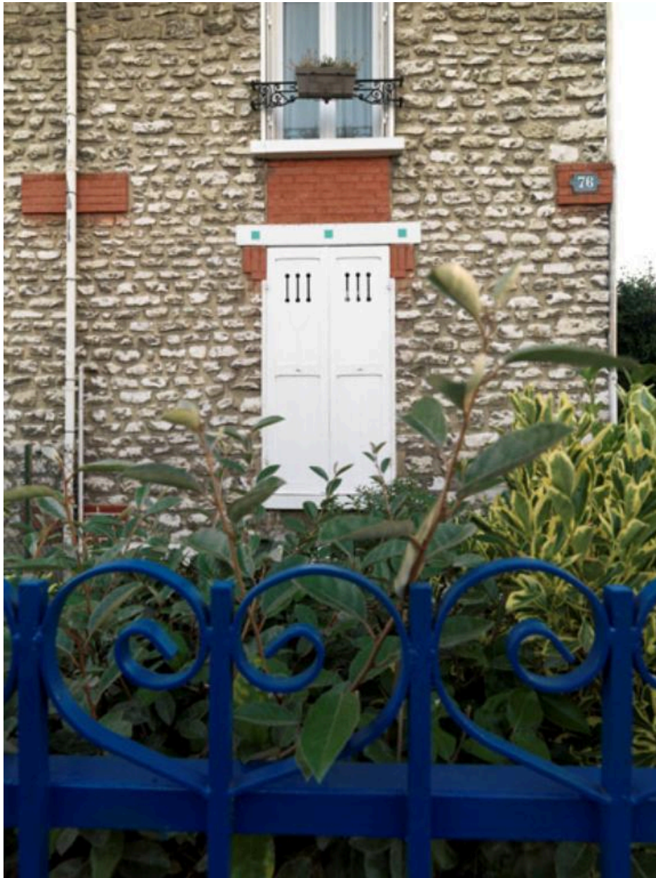
Vue de détail du décor de briques, maison-jumelle 76-78 rue Saint-Vincent (type A).
