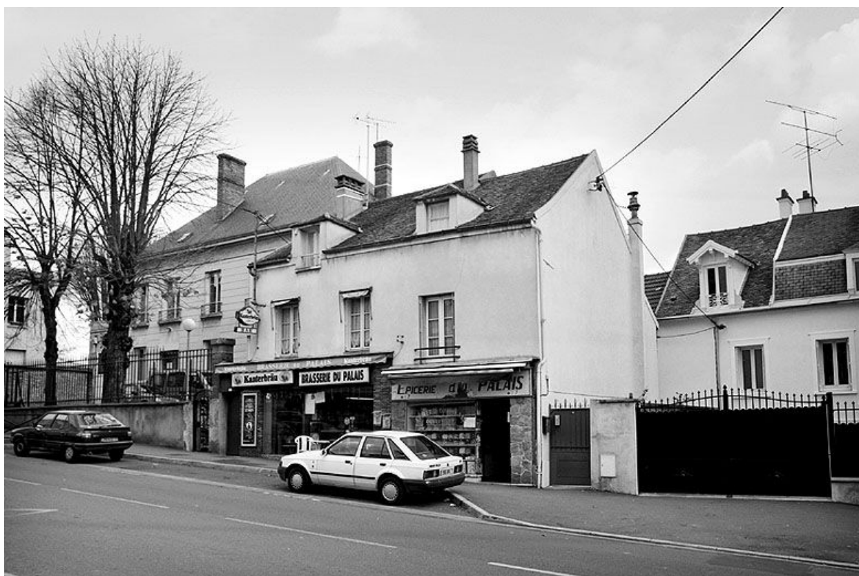
Élévation ouest, sur la rue du général de Gaulle.
