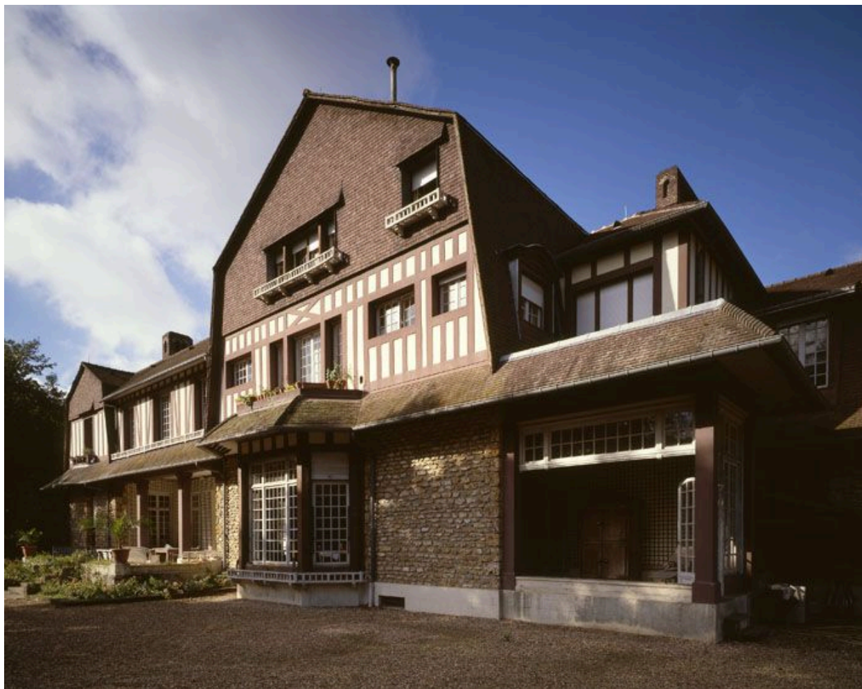
La façade panoramique.
