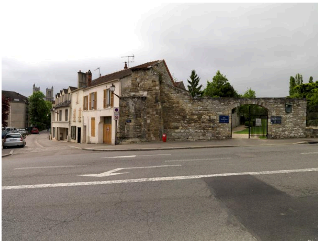
Vestiges de l'ancienne porte Chante-à-l'oie.
