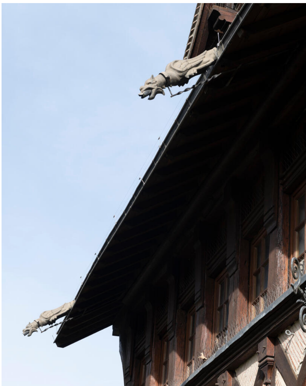
Gargouilles en façade sud.
