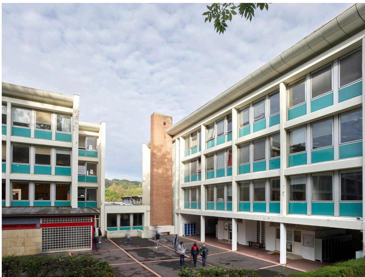
Le bâtiment du collège (façade postérieure sur cour).
