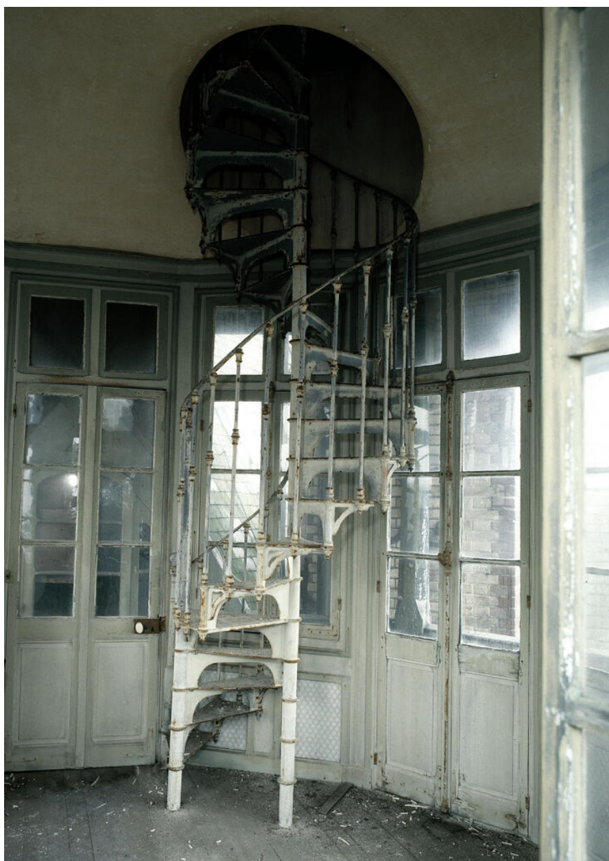
Vue de l'escalier métallique de la tour.
