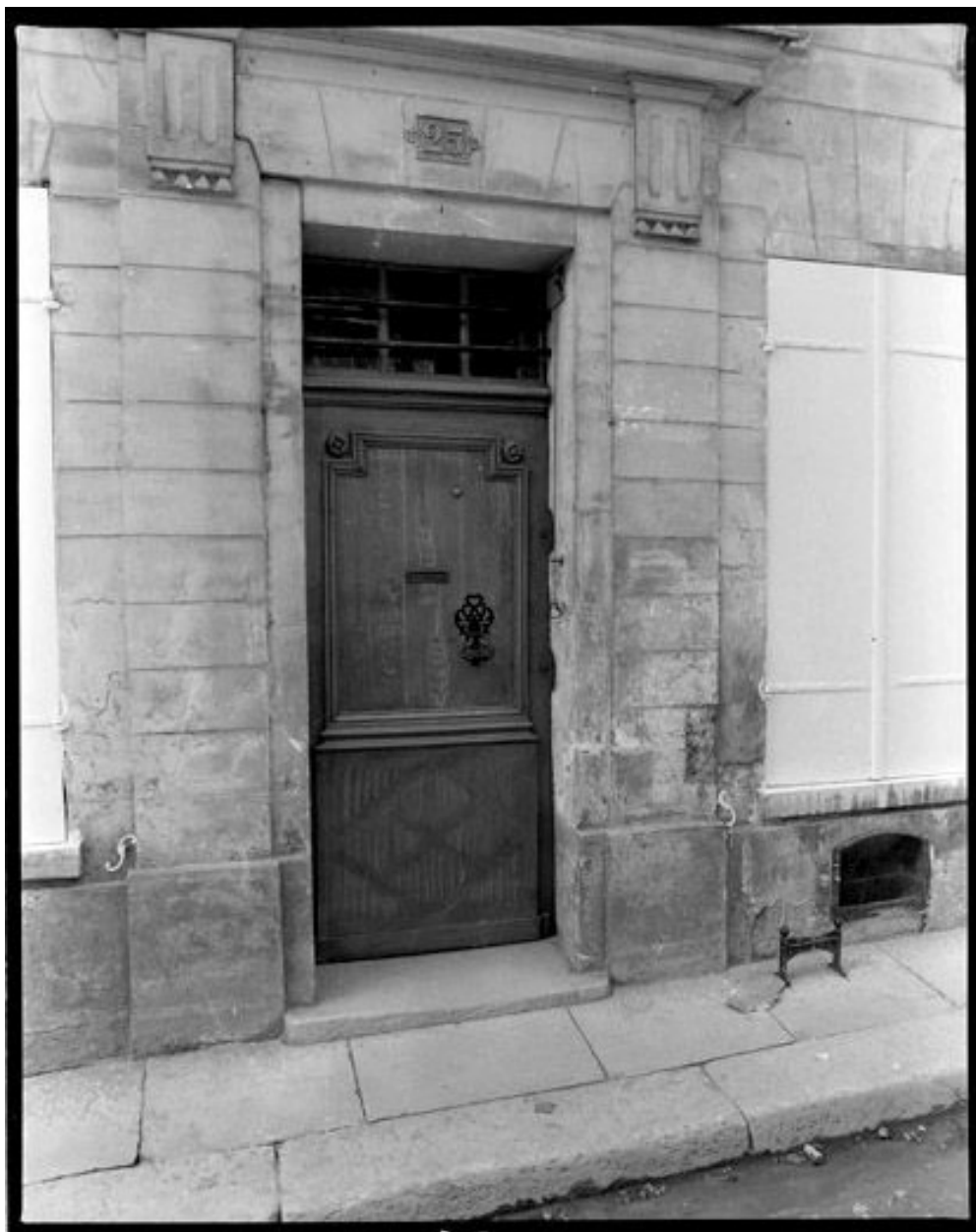
Maison, Sangle (rue de la) 25. Vue de la porte d'entrée.
