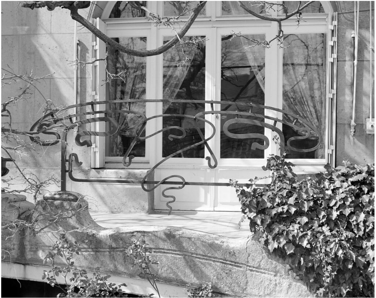
Façade antérieure, détail d'un garde-corps en fer forgé.
