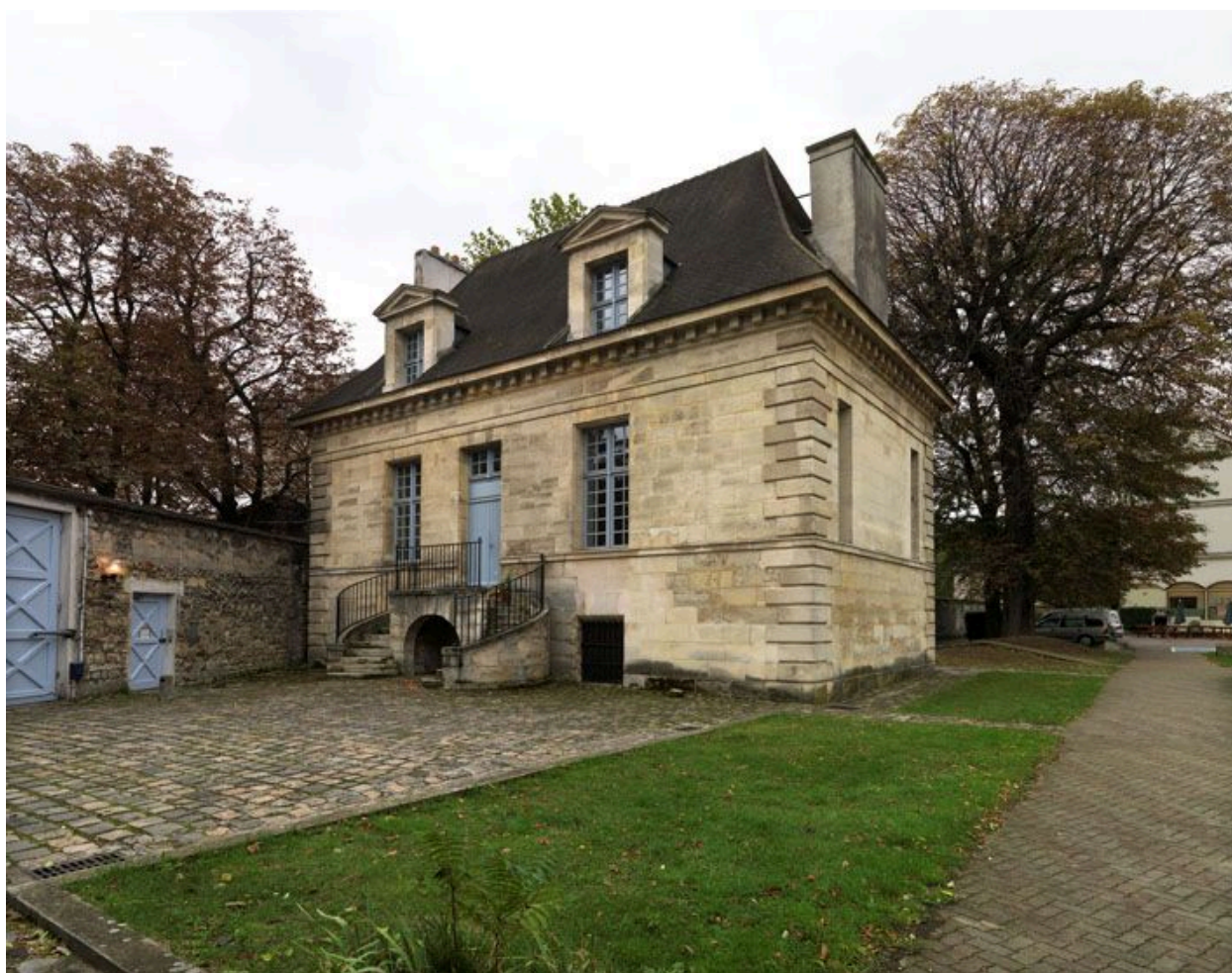
Paris 14e, Observatoire (avenue de l') 44. Maison du Fontainier ou grand regard de l'Observatoire (regard XXVII) : façade nord. Pavillon de style Louis XIII, construit entre 1619 et 1623.
