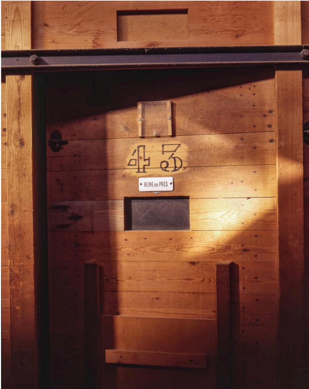
Détail de la porte d'un silo. Une trappe permet de soutirer les plantes, le hublot assure le contrôle du remplissage du silo. La porte elle-même permet un accès aisé au silo pour son nettoyage.
