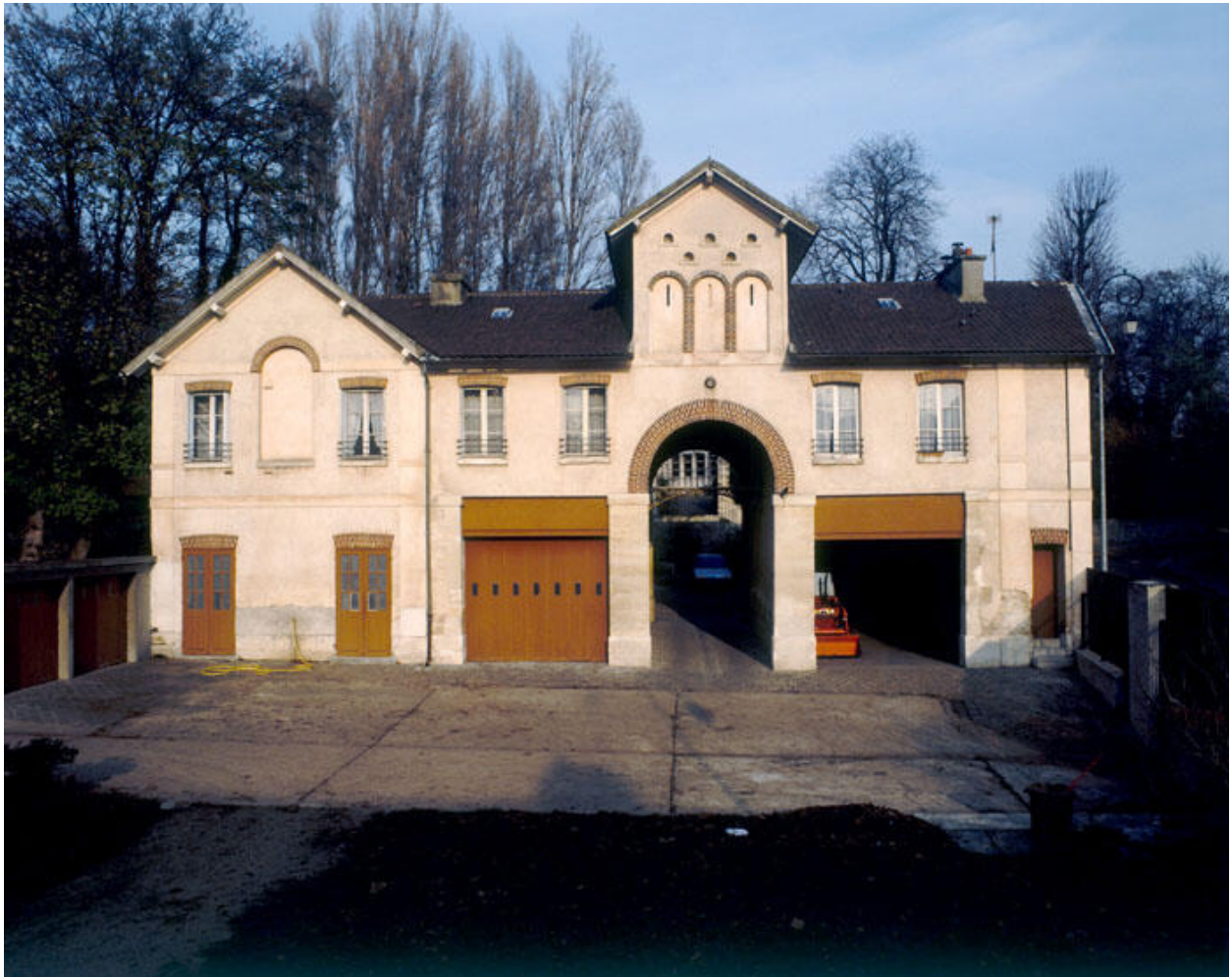
Façade sud des communs de l'ancienne maison Arouet, de style italianisant.
