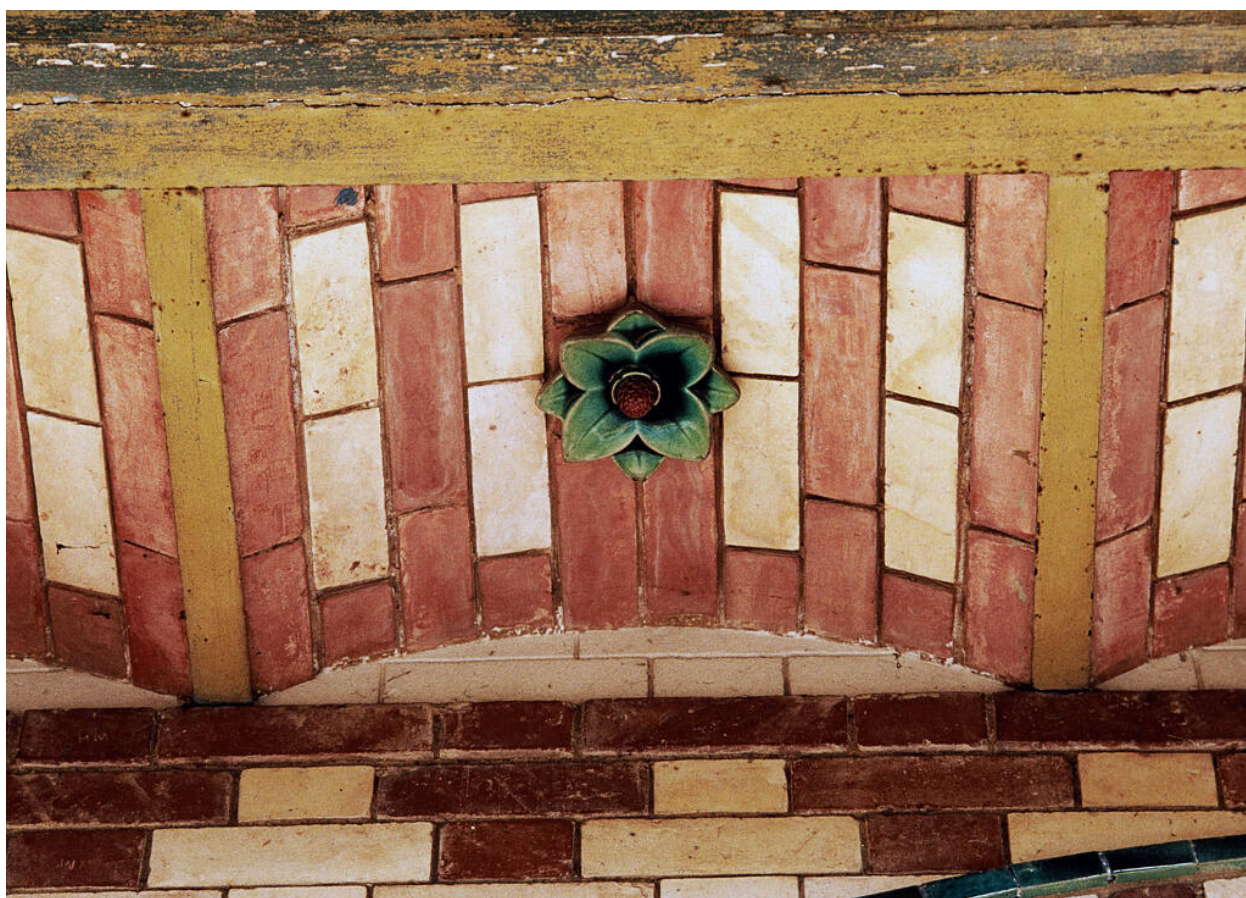
Détail des voûtains de brique au dessus de la porte d'entrée.
