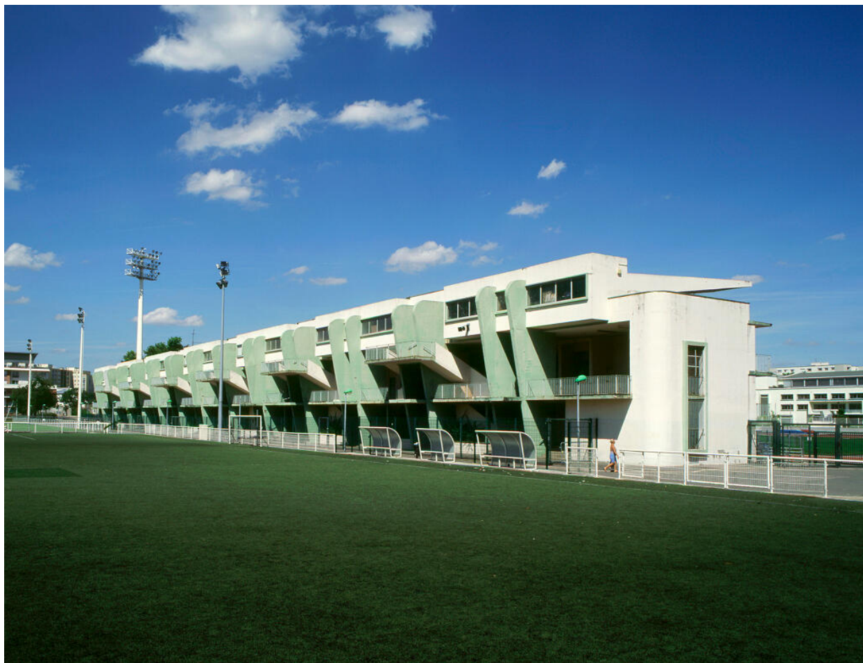
Façade antérieure de la tribune du stade principale. Stade Auguste Delaune
