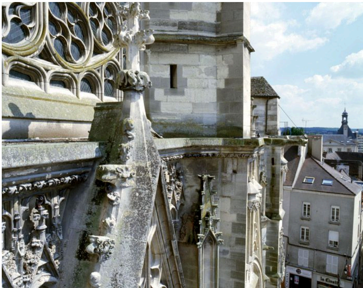
La façade occidentale : panorama au niveau du sommet du gâble du portail central, depuis l'échafaudage dressé pour la restauration de la base de la tour nord (2008).
