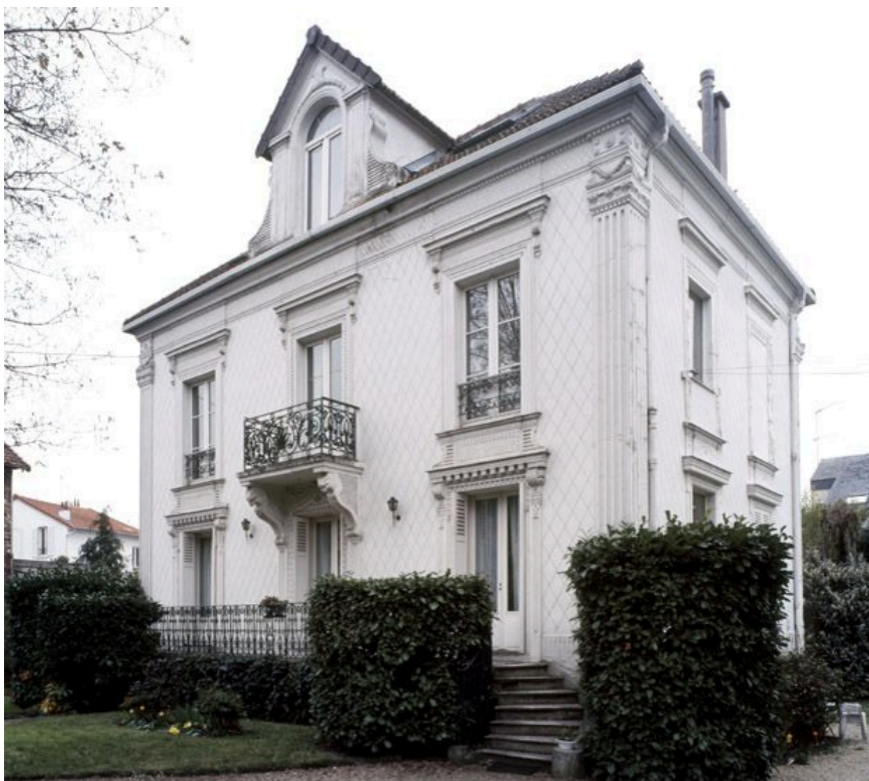
Maison, 13 avenue Charles V. Vue d'ensemble.
