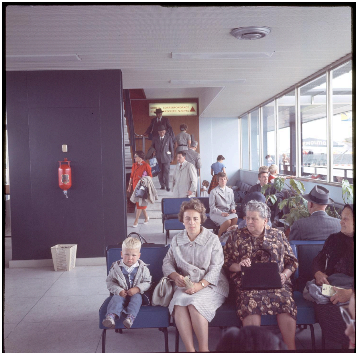
1961, salle d'embarquement, rez-de-chaussée coté piste.
