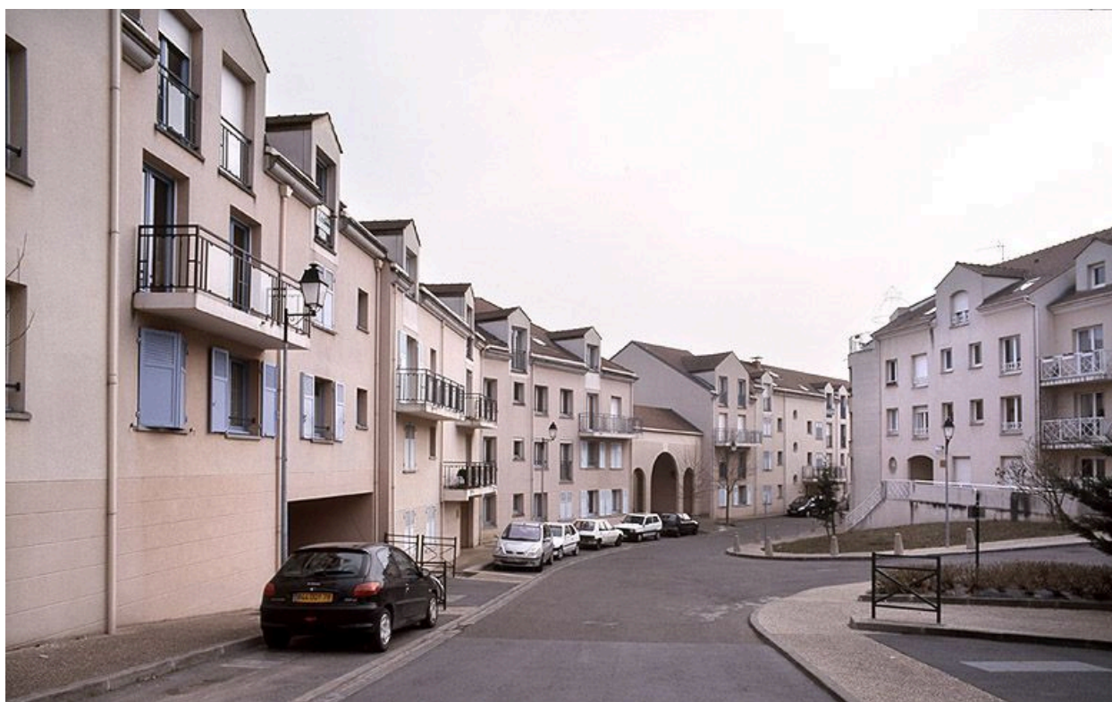
Andrésey. Vue de la rue du Pleyon construite selon les directives de la ZPPAU.
